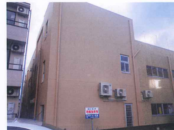
外壁塗装工事
