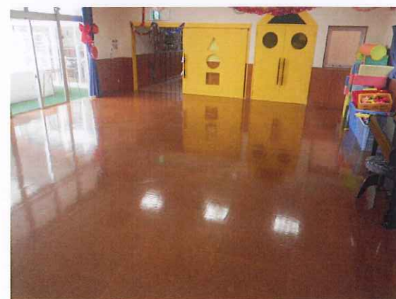
遊戯室 床張替工事
