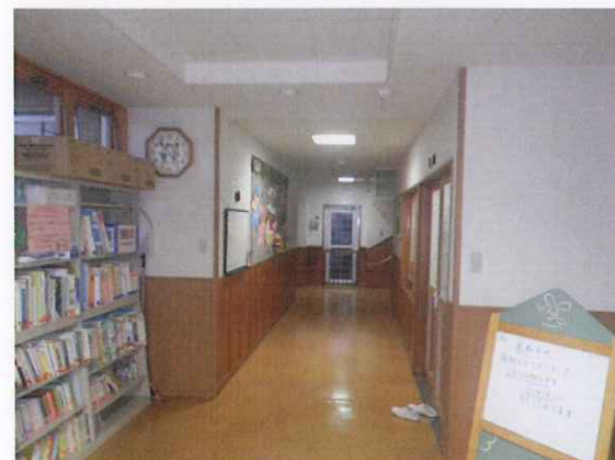
1F 廊下 床・壁張替工事
