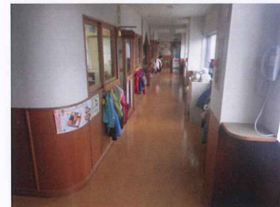
2F 廊下 床・壁張替工事
