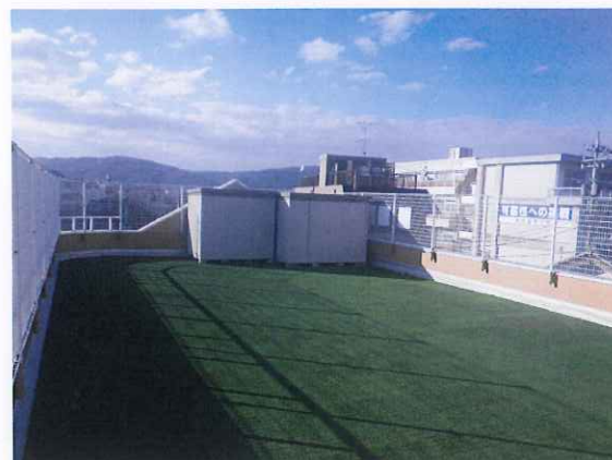
屋上シート防水工事
